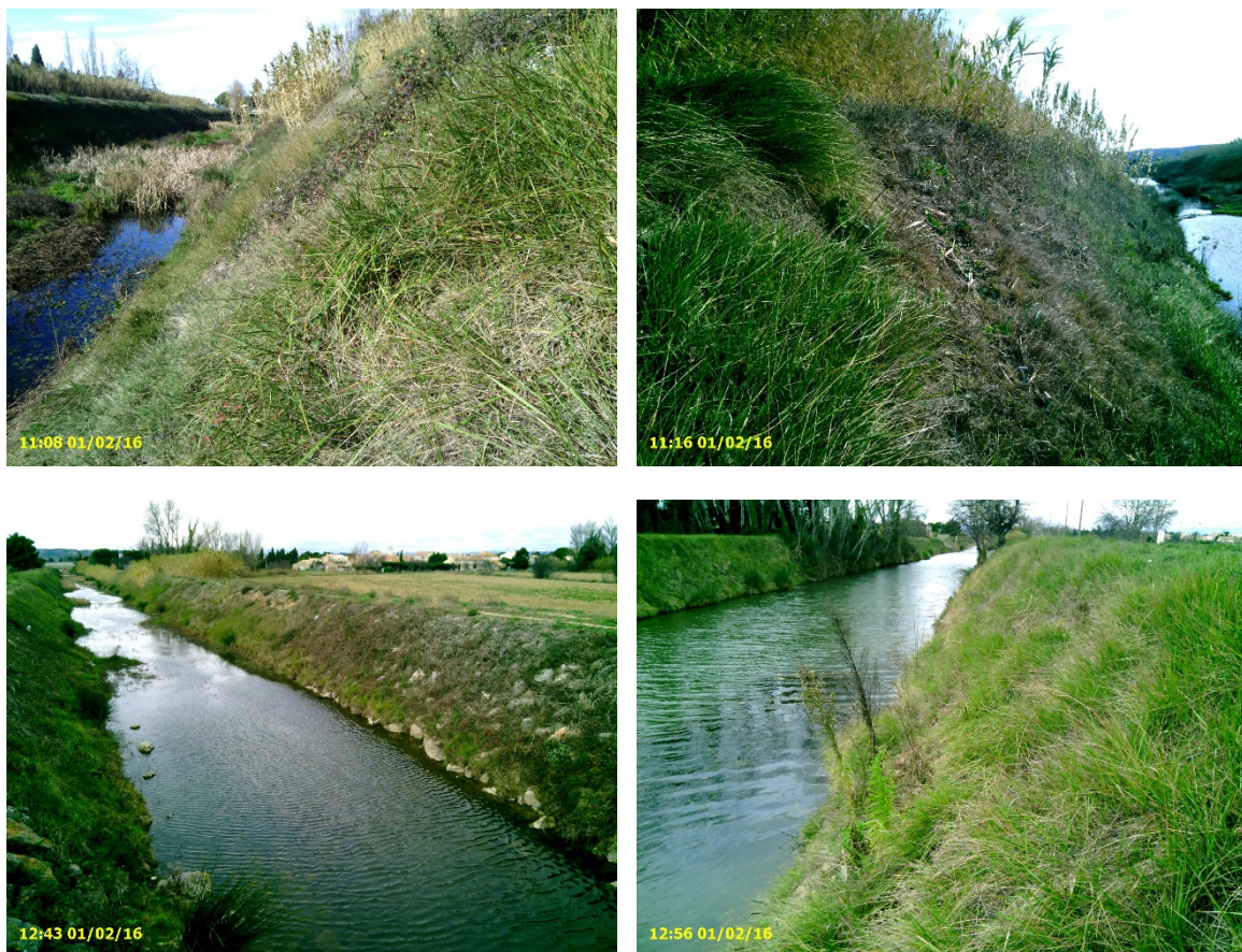
Figure 37: Forte pente des talus coté rive
