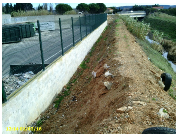
Figure 11: Tronçon entre la déchèterie et le pont de Lunes
