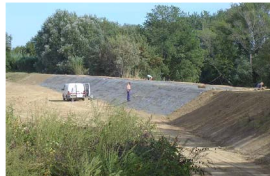
Digue en reconstruction, après pose de l'Enkamat
