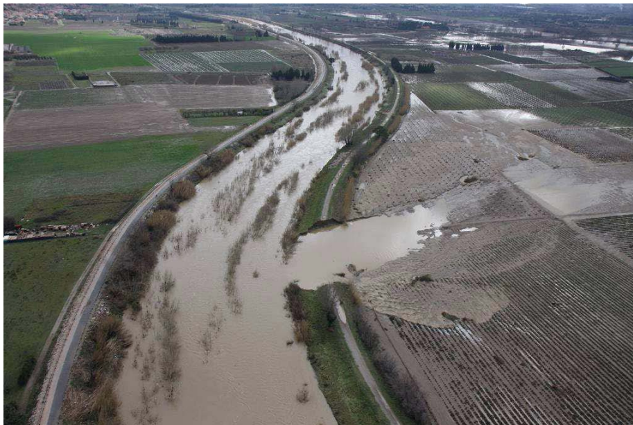
Figure 61 : brèche de Pia sur l'Agly - crue du 6 mars 2013 - (photo : protection civile des Pyrénées-Orientales)
