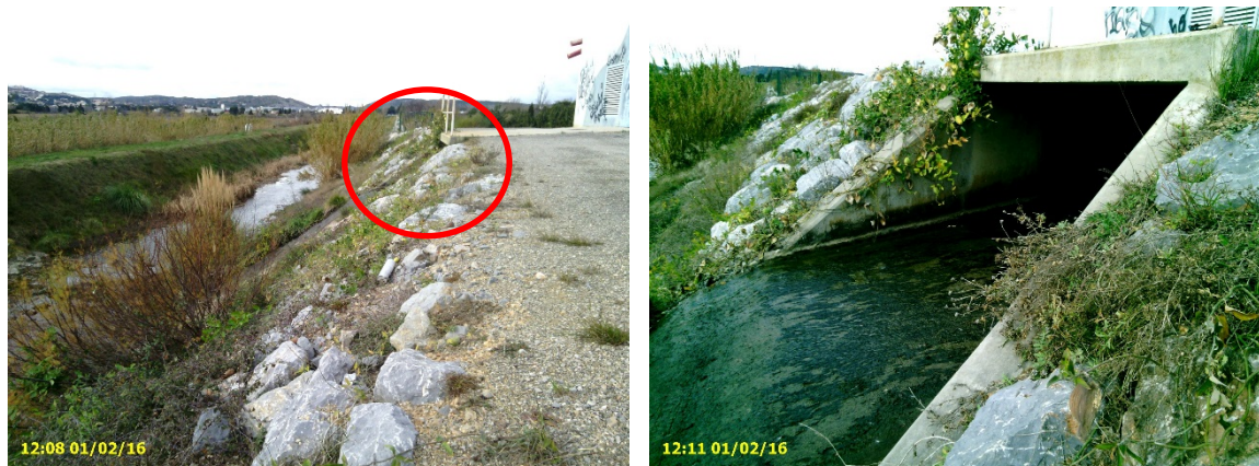
Figure 24: OH du bassin de rétention
