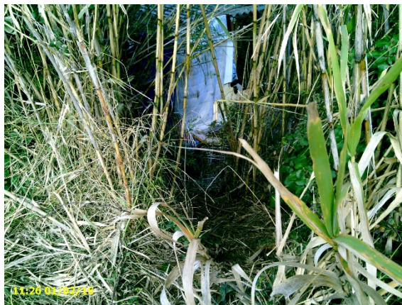
Escaliers taillés dans le talus coté val (PK 0+480)
