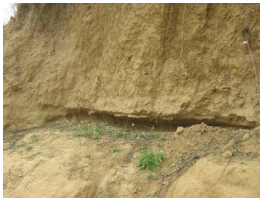
Terrier apparent au niveau des talus de la brèche
