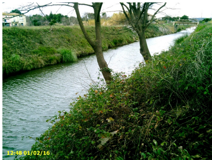
Figure 13: Tronçon entre le pont de la Cafforte et le pont de l'A9
