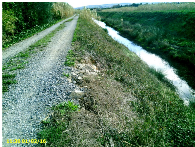
Figure 9: Tronçon entre la passerelle de St Crescent et la déchèterie
