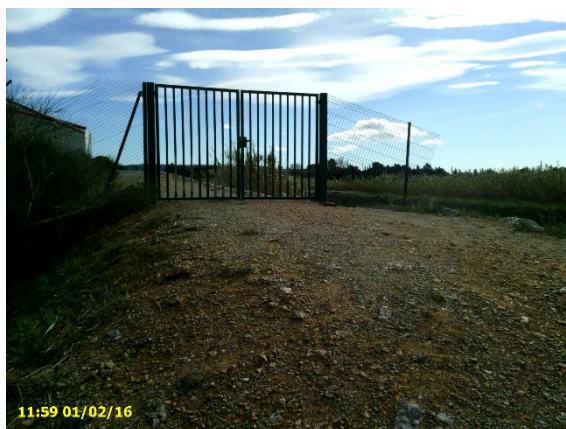
Barrières aux PK 0+930 et PK 1+345
