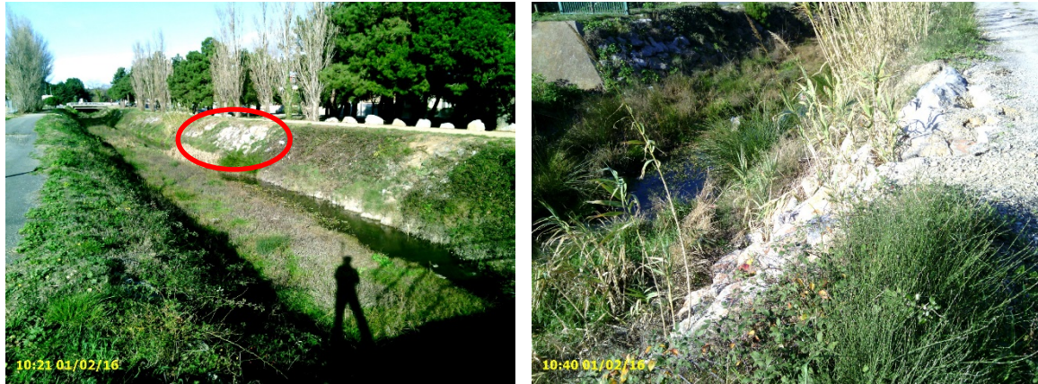
Figure 34: Renforcement de talus coté rive en enrochements
