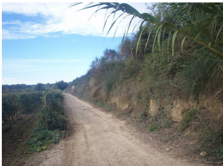
Figure 58 : Rabotage du pied de digue du Gailhousty
