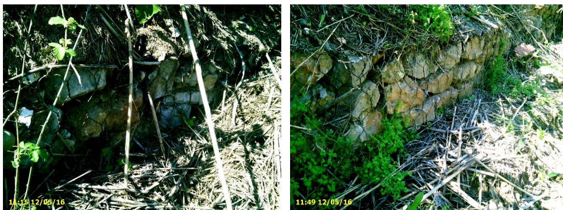
Figure 43: Cages gabions en pied côté val du talus
