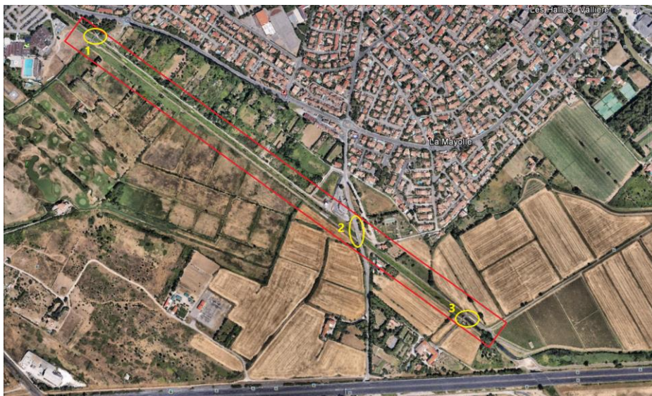
Figure 72 : Couloir endigué - Ouvrages traversants interceptés
