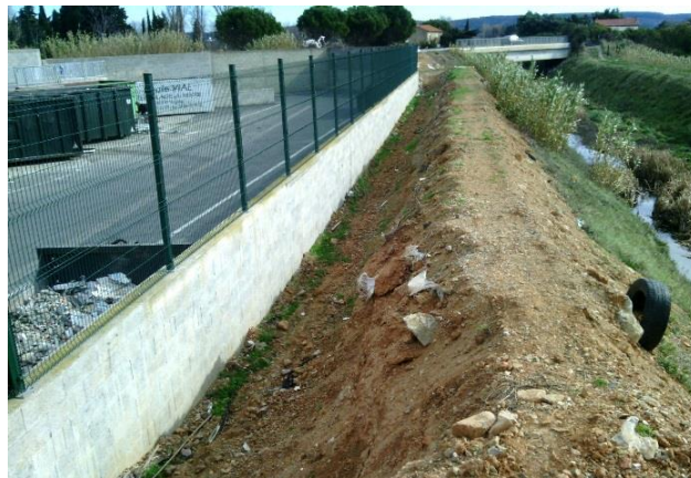
Tronçon entre la déchèterie et le pont de Lunes
