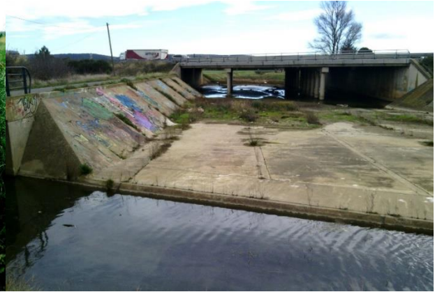
Seuil du pont de l'A9
