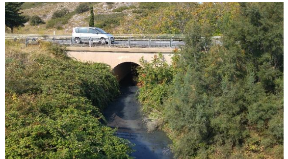
Vue du pont 4 x 2,9 m sur la RD 6113
