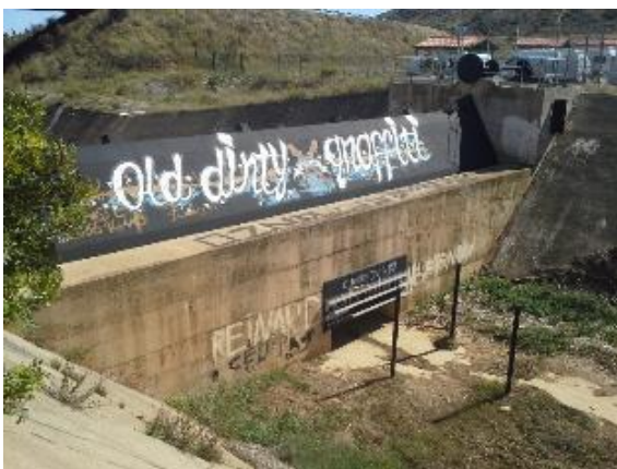
Vue de l'ouvrage mobile de vidange de la retenue Cap de Pla –vue depuis l'amont
