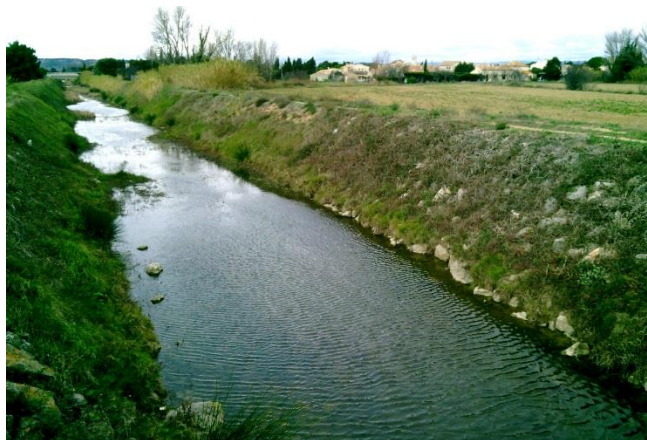
Tronçon entre le pont de Lunes et le pont de la Cafforte
