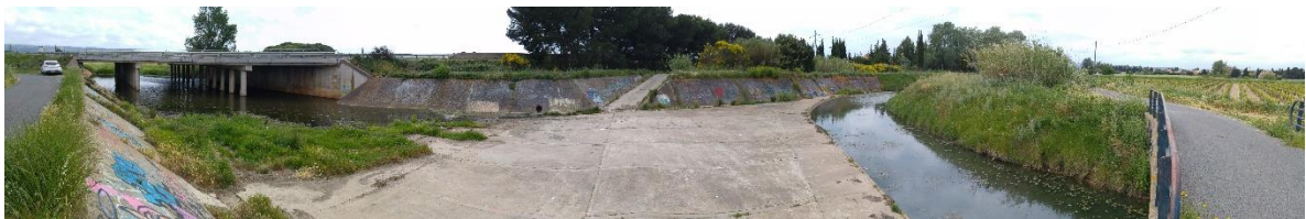
Ouvrage de franchissement de l'Autoroute A9 et déflueuse des deux bras du Rec de Veyret
