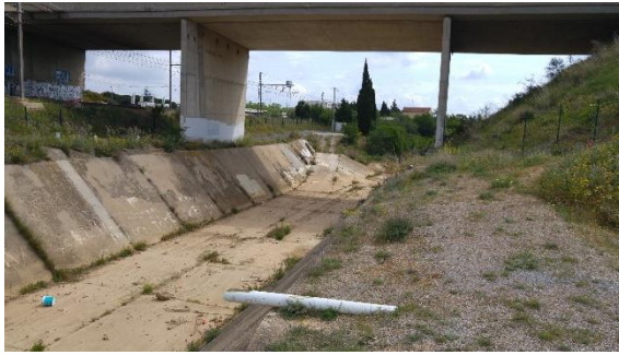
Passage du Rec de Veyret sous la RD 6009
