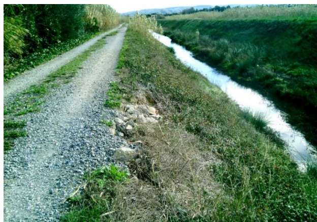
Tronçon entre la passerelle de St Crescent et la déchèterie
