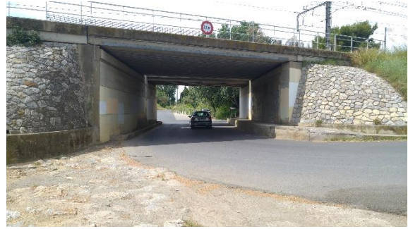
Passage du Rec de Veyret sous la voie ferrée
