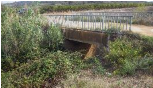
Vue de l'ouvrage 2,9 x 3,1 m sous l'ancienne route de Bizanet
