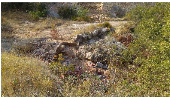
Ruisseau des Tinos en amont de la RD 6009
