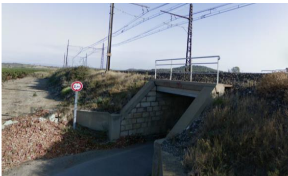
Vue de l'ouvrage sous la voie ferrée 3 x 2,1 m – Point bas (ruisseau Maire)
