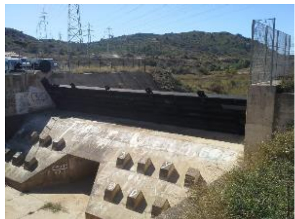
Vue de l'ouvrage mobile de vidange de la retenue Cap de Pla –vue depuis l'aval
