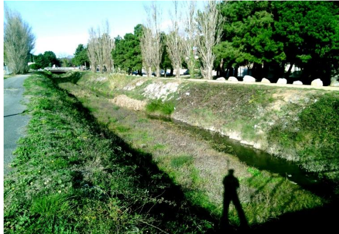
Tronçon entre le pont de l'avenue du Général Leclerc et la passerelle de St Crescent
