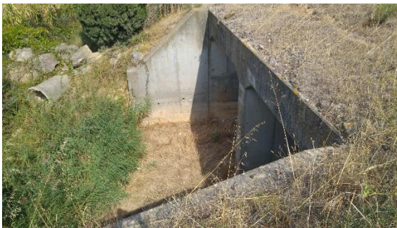
Ouvrage de franchissement de l'Autoroute A61
