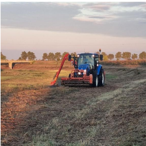
Entretien mécanisé des digues
