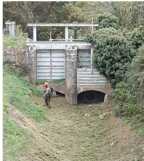
Débroussaillage manuel au droit d'ouvrage
