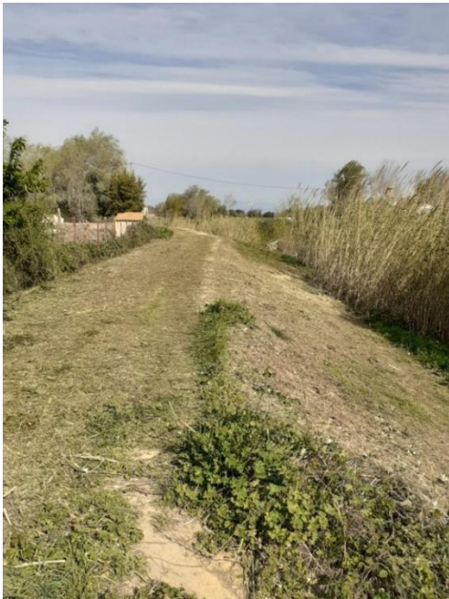
Entretien mécanisé des digues
