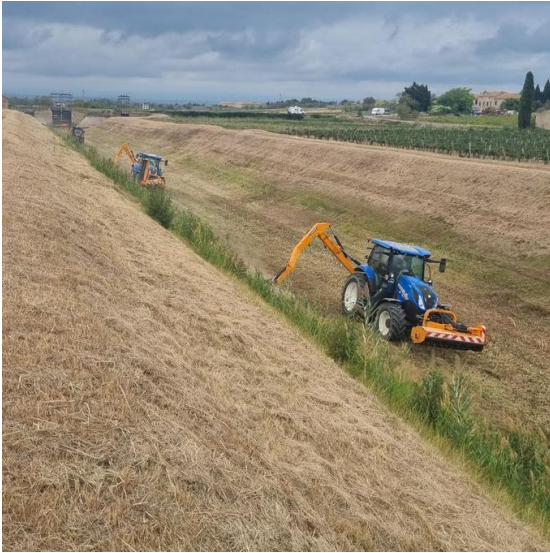
Entretien mécanisé sur des canaux de ressuyage
