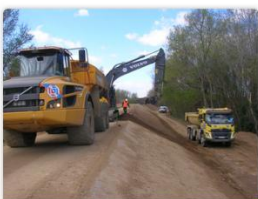
Travaux Digués et Déversoirs de bord d'A...
