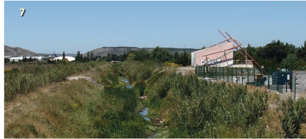
7. depuis le pont de Lunes, vers la déchetterie et le nord-ouest du projet
