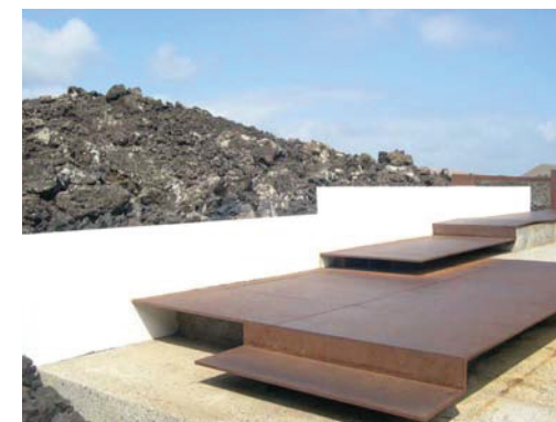
Travail sur un belvédère pour mettre en scène les vues sur le paysage
