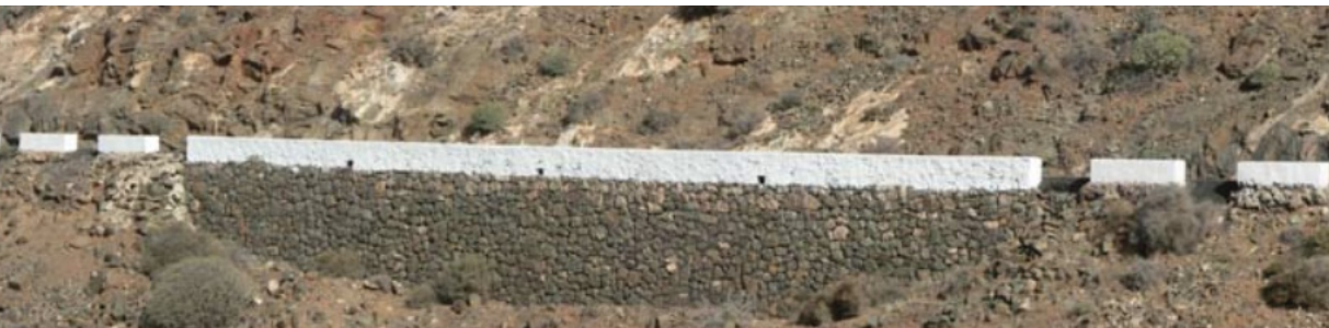
Travail sur la limite de la voie dans des espaces valonnés: murets, grand caniveau, limite plus ou moins franche; remblais et déblais travaillés de façon soignée (mur ou roche à nu)
