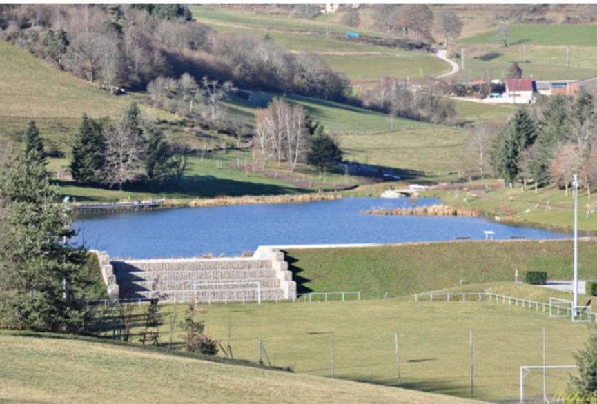
Lac du Ronzey à Yseron (69) Agence 2br Gradins en gabion (surverse) offrant aussi un accueil pour les spectateurs devant le terrain de foot
