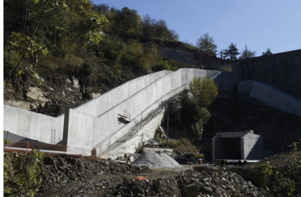
Barrage du Pas du Riot (42) Nouveau déversoir en béton
