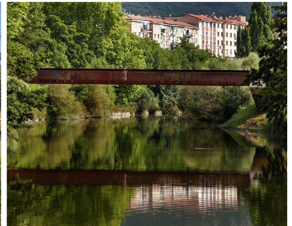
Pedestrian Bridge in Aranzadi Park - Peralta Ayesa Arquitectos + Opera ingeniería
