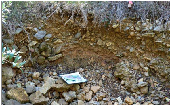
Figure 12 : alluvions argilo-caillouteuses au droit de l'ouvrage
