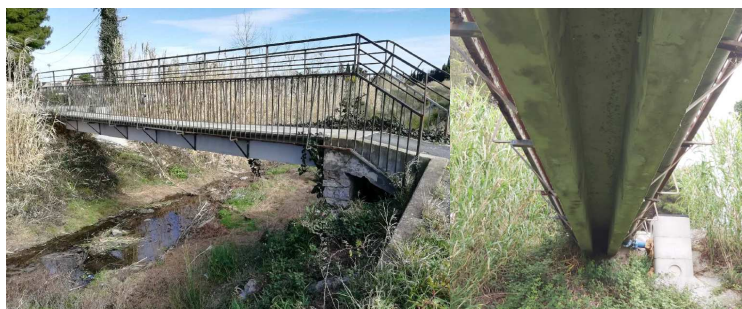
Figure 55 : Photos de la passerelle existante
