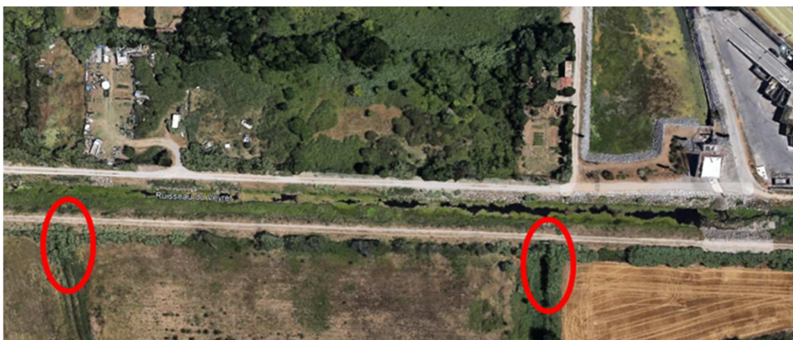
Figure 62 : Localisation des ouvrages existants
