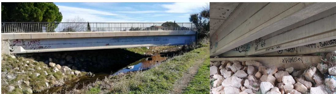
Figure 59 : Photos de l'ouvrage existant
