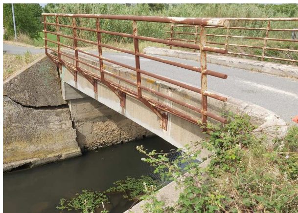
Figure 61 : Photo de l'ouvrage existant
