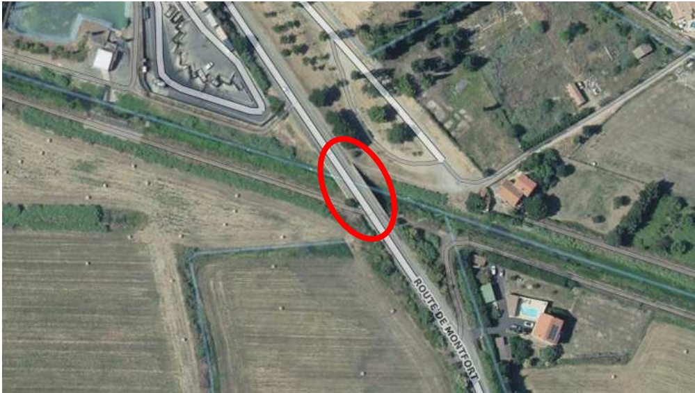
Figure 58 : Localisation de l'ouvrage d'art
