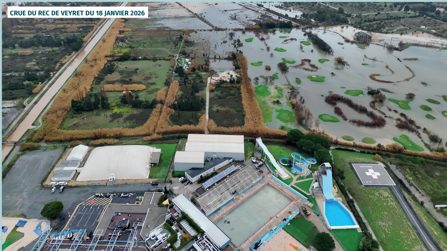
Inondation de la plaine en sortie de l'Espace de Liberté - Narbonne
