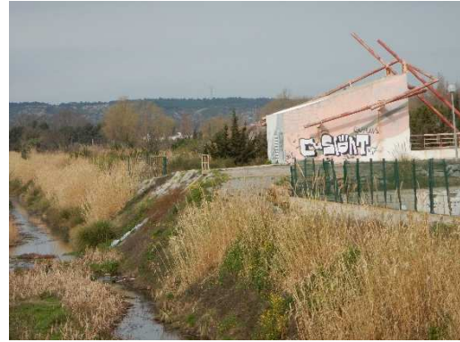
Talus côté rivière vu depuis le pont de la route de Montfort
