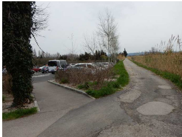
Vue de la crête de digue vers l'aval près du parking
