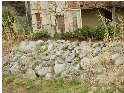
Protection du talus devant la maison encastérée avec palplanches affleurantes en crête et enrochement sur le talus côté rivière
