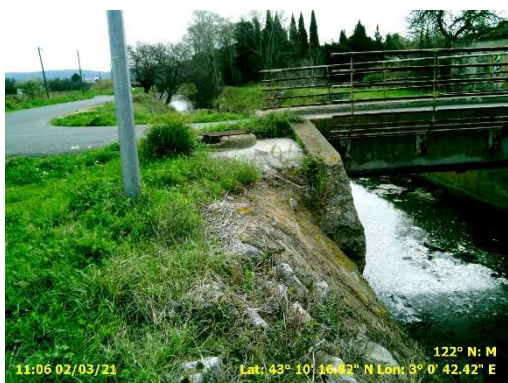
Point 483 : pont du chemin de la Cafforte vu de l'amont vers l'aval
