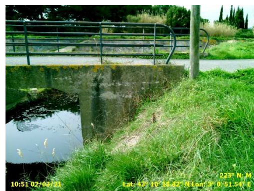
Point 491 : pont du chemin de Saint-Charles vu de l'aval vers l'amont
