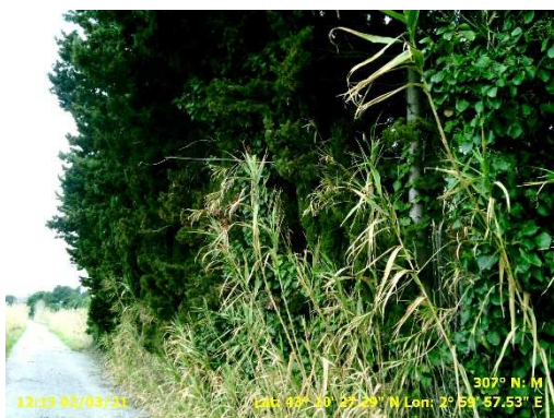
Point 444 végétations ligneuses généralisées sur talus côté terre
