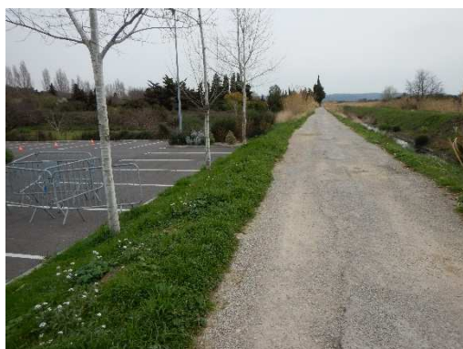
Digue au niveau du parking vue vers l'aval
