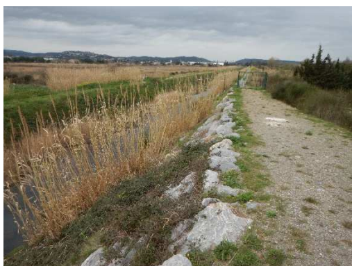
Vue de la crête de digue vers l'amont depuis la station de pompage
