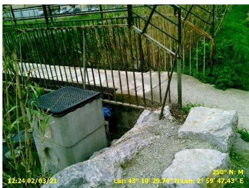
Point 435 : passerelle métallique piétonne avec regard réseau d'eau potable ( ?)
