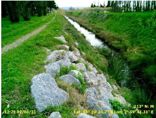
Linéaire 134 : Encochements libres disposés en pied de talus - rive droite sur environ 100 m de long
