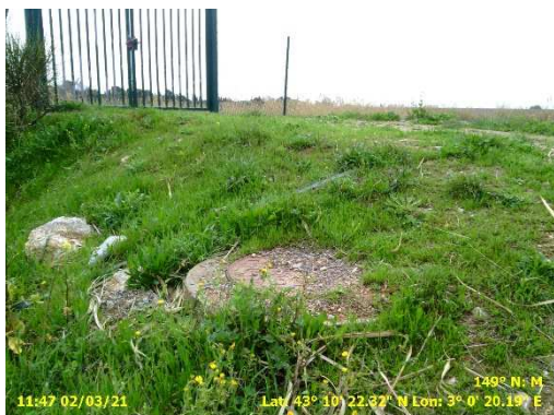
Point 463 Regard sur le haut du talus côté terre en amont de la station
