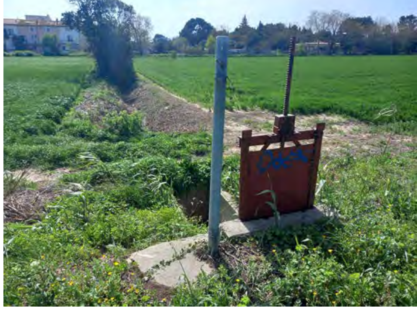
▼ Une prise d'eau à l'amont du seuil
