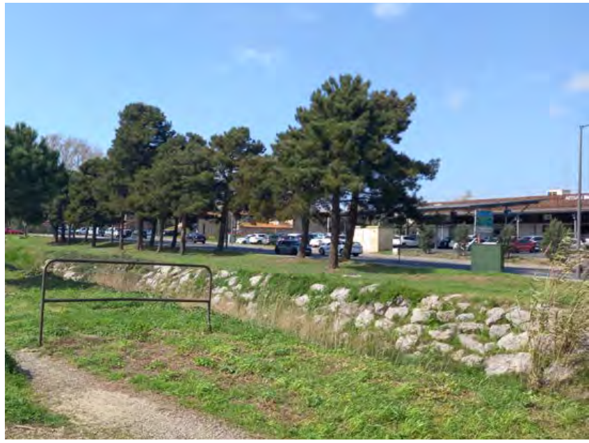
▲ Les berges enrochées au droit de l'Espace Liberté
