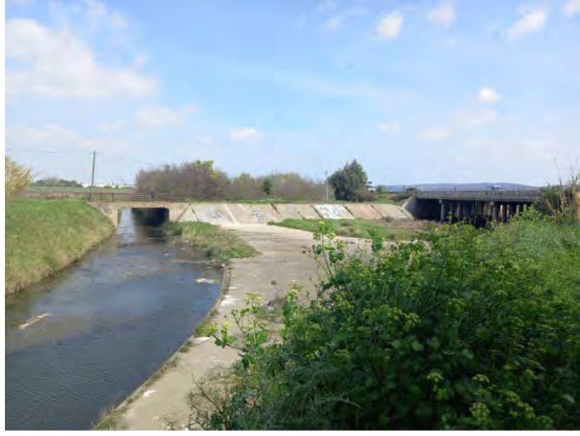
▲ le seuil bétonné au niveau de l'A9
