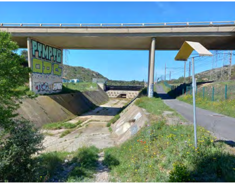
▲ L'endiguement du Rec au passage sous la RD6009, contournement sud de Narbonne
