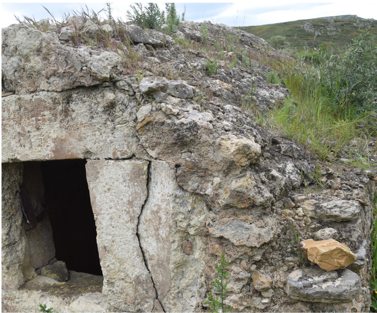
Altération des enduits et développements biologiques sur la montjoie n°113
