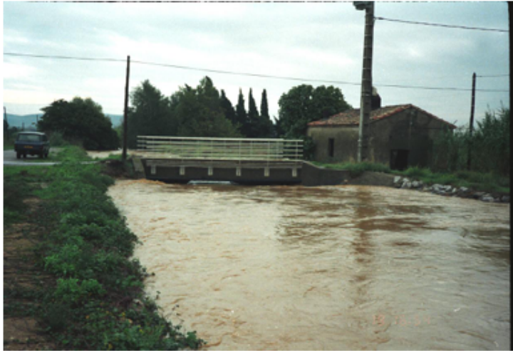
le pont de La Cafforte depuis l' amont, daté 16 :54
