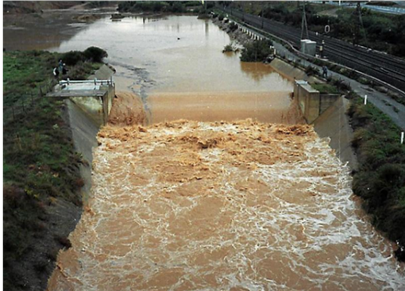
Le barrage de Cap de Pla, peu après l' affaissement de la porte métallique. (Non horodaté)
