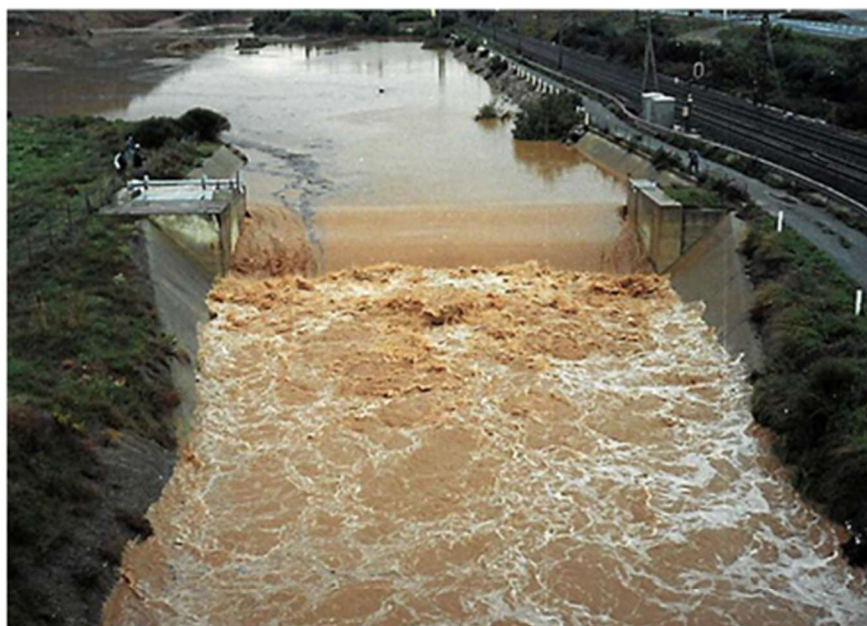
Le barrage de Cap de Pla, peu après l'effacement de la porte métallique. (Non horodaté)
