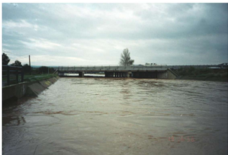
au déversoir de La Cafforte, daté 16 :56
