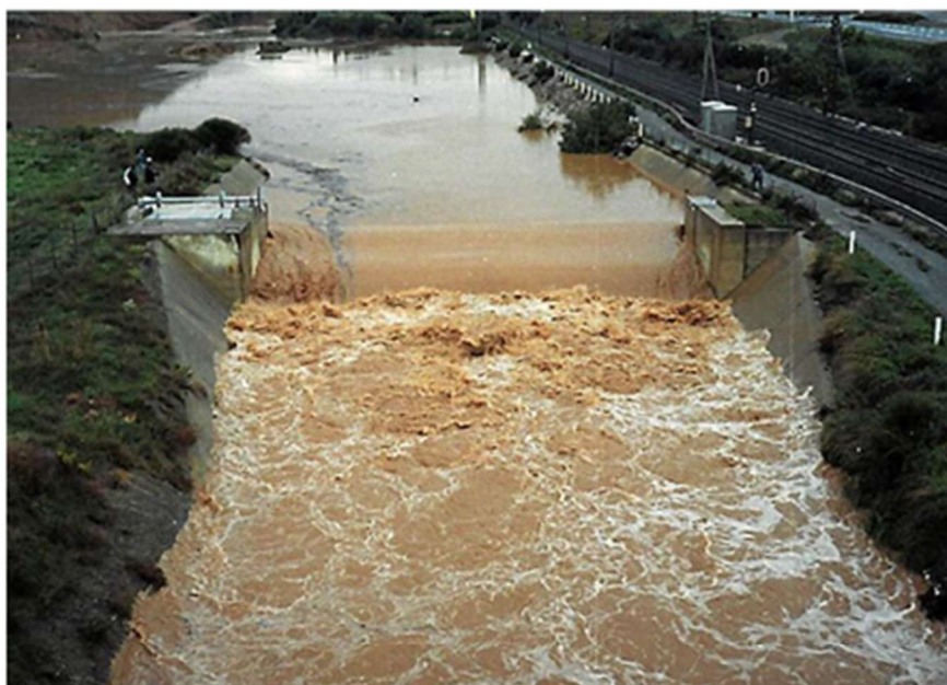
Le barrage de Cap de Pla, peu après l'effacement de la porte métallique. (Non horodaté)
